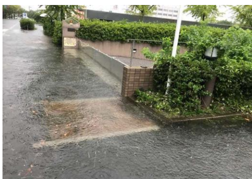
冠水した道路と本館地下駐車場入口 (令和元年 8 月 2 8 日)
